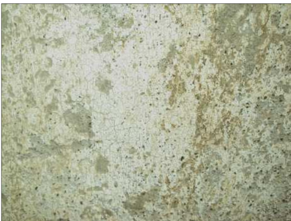
Fig. 5: Dettaglio finitura della fascia superiore imbiancata a calce
