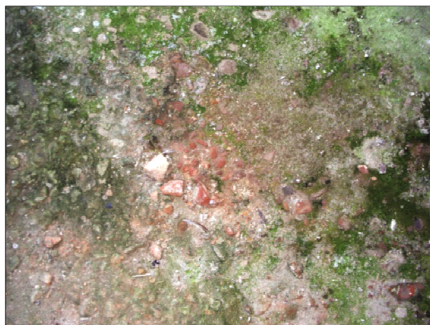
Fig. 17: Pavimento del Calcatorium: dettaglio delle patine verdi sul cocchiopesto.
