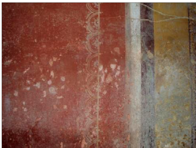
Fig. 26: Triclinio, 'velature' di calcare sulle superfici pittoriche.
