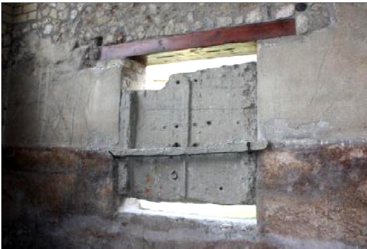
Fig. 45: Calcatorium, calco in cemento dei battenti della finestra. Fig. 46: Ingresso, calco in cemento di un battente del portone.
