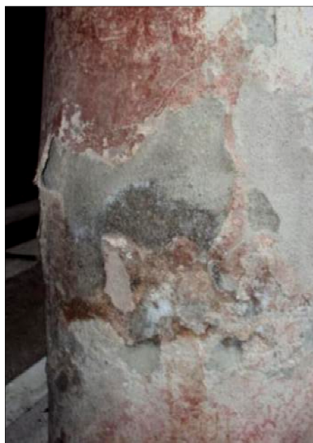
Fig. 31: Portico, disgregazione e sollevamento dell'intonaco delle colonne, stuccature con malta a base di calce o cemento.
