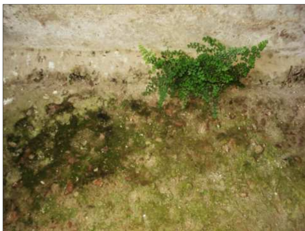
Fig. 16: Pavimento del Calcatorium: piante superiori, guano e microflora patogena presente sottoforma di patine verdi.
