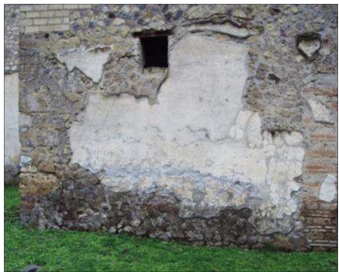
Fig. 11: Intonaco monocromo esterno, prospetto Sud.
