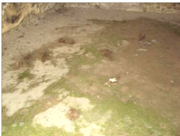
Fig. 18: Pavimento del Triclinio: nidi di piccioni caduti dalle travi della copertura, guano e microflora patogena.
