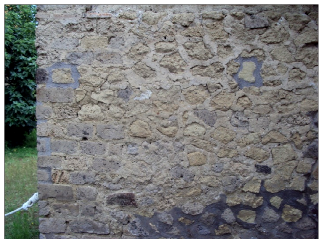
Fig. 2: Muratura originale con cantonale; stuccature cementizie.
