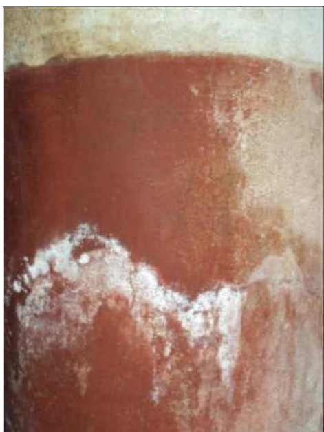
Fig. 30: Portico, efflorescenze saline sulla porzione inferiore delle colonne.
