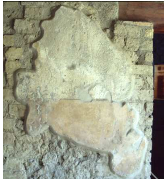
Fig. 4: Intonaco interno dell'Ingresso, con fascia superiore bianca al grezzo e fascia inferiore giallo ocre con finitura liscia.
