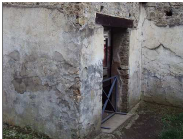
Fig. 13: Cucina: fenomeni di degrado legati all'umidità di risalita.
