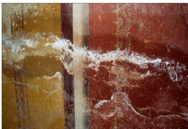
Fig. 28: Triclinio, efflorescenze saline: la pellicola pittorica risulta sollevata a sfoglie e inglobata nelle 'barbe' saline.
