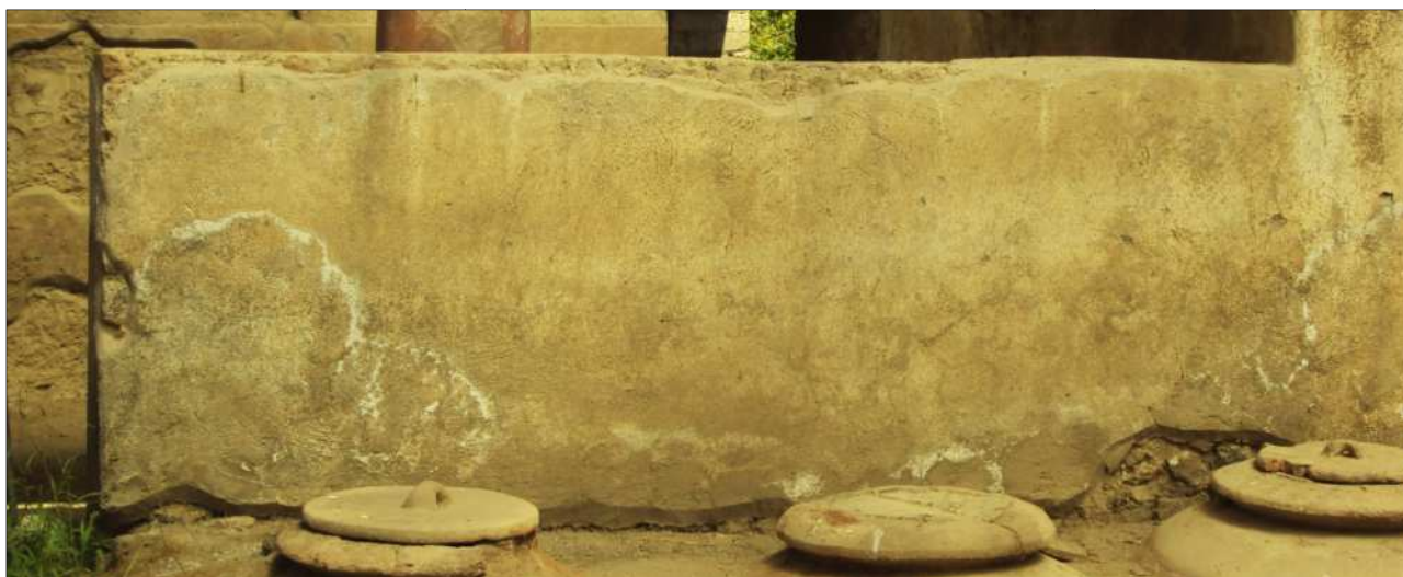
Fig. 9: Cella Vinaria: esempio di efflorescenze saline nella parte inferiore della muratura
