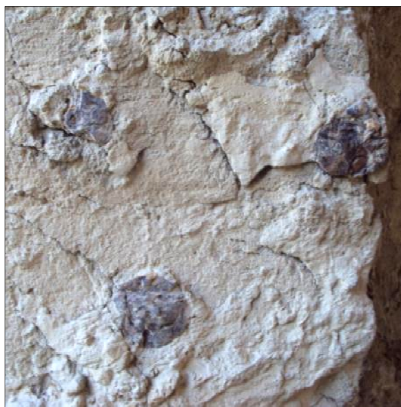
Fig. 38: Ingresso: chiodi originali dei battenti del portone, inglobati nel calco in cemento.
