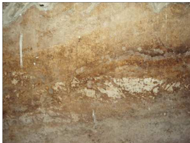
Fig. 8: Calcatorium: esempio di annerimento (sopra) e velatura di calcare (sotto) nella parte inferiore della muratura.
