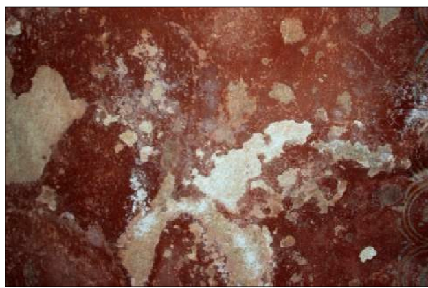
Fig. 29: Triclinio, sollevamento e caduta della pellicola pittorica, disgregazione dell'intonachino.
