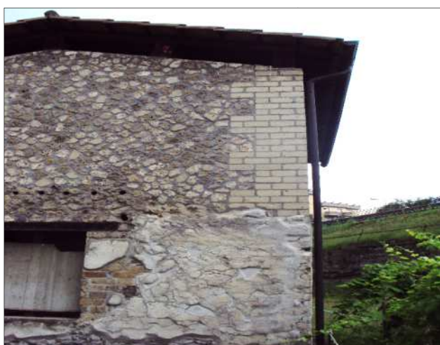
Fig. 12: Calcatorium: pannello intonacato riapplicato.
